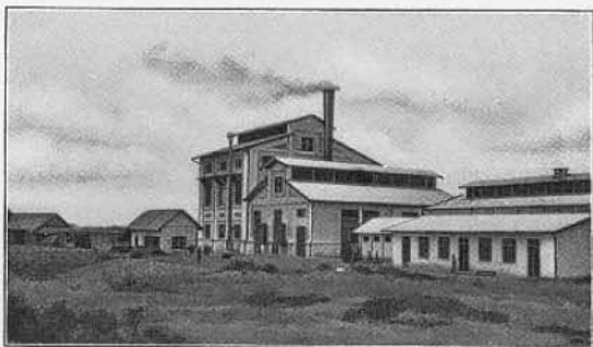
Bild 17. Malabar (Java). Dampfkraftwerk Dajuehkolot. Außenansicht.
