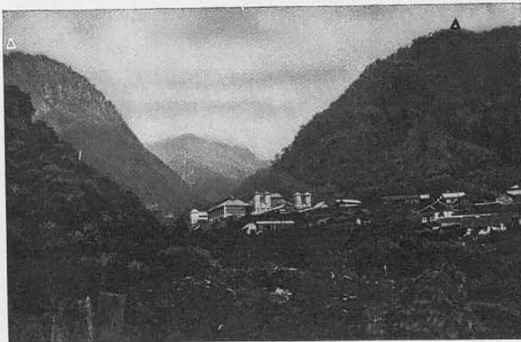
Bild 11. Malabar (Java). Die Schlucht mit den Bergkuppen, auf denen die Halteseile für die Bergantenne verankert sind.
